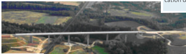
Le viaduc de Jaulny est le plus haut de la Ligne, avec une hauteur culminante de 50 mètres.
